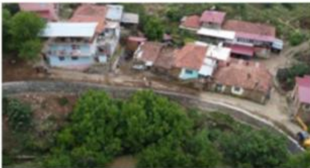
Kahvederesi yol kenarı istinat duvarı
