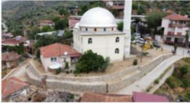
Karahallı Mahallesi Cami Etrafı İstinat duvarı
